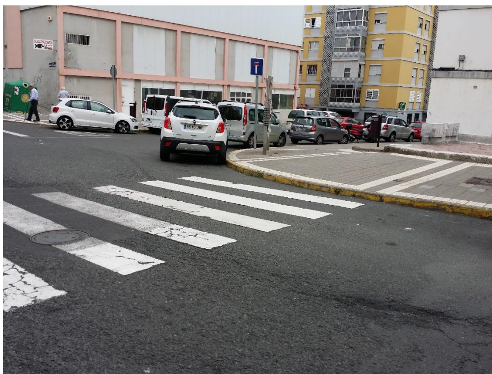
Img6. Cruce de calles sin rebaje en paso de peatones.
