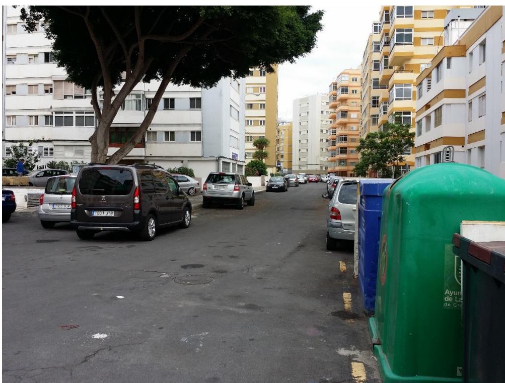
Img.2. Aparcamiento interior con pavimento en mal estado.
