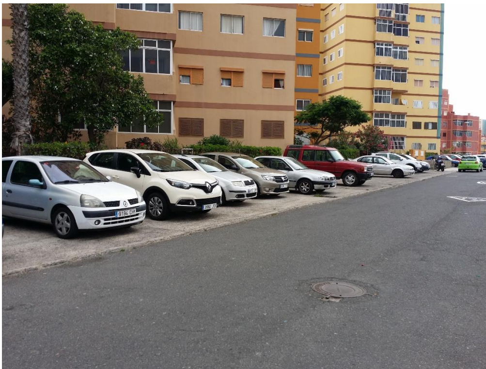
Img.9. Aparcamiento de fondo de saco con pavimento en mal estado y sin delimitar.
