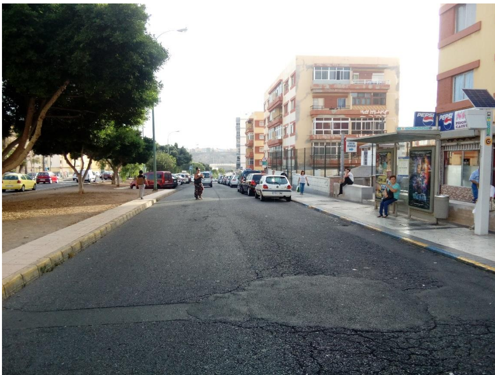
Img.11. anchos insuficientes en acera y mal estado de la calzada
