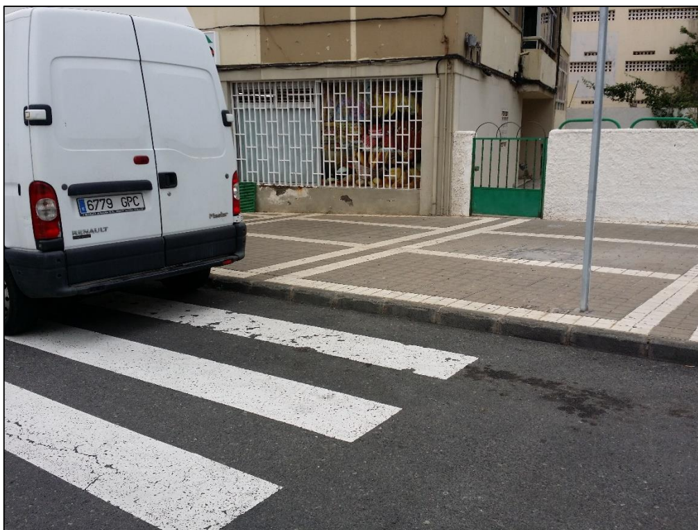
Img.3. Paso de peatones sin rebaje.
