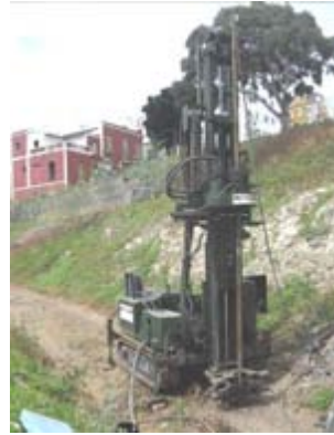
Vista del Sondeo 2
