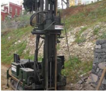
Vistas del sondeo S-1
