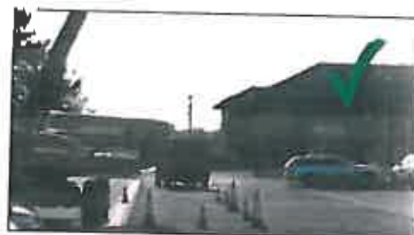
Figura 20. Delimitación de zona de trabajo.
