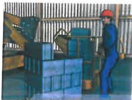
Figura 17. Plataforma de trabajo sobrecargada.
