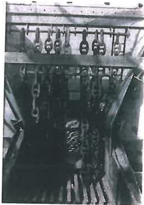
Foto 1: Cortina de cadenas dispuesta a la salida de la tolva de recepción, para la retención de los bloques gruesos
