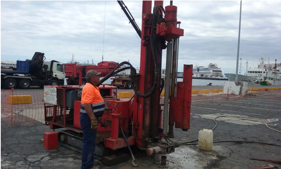
Foto 40: Perforadora instalada en Sondeo 8
