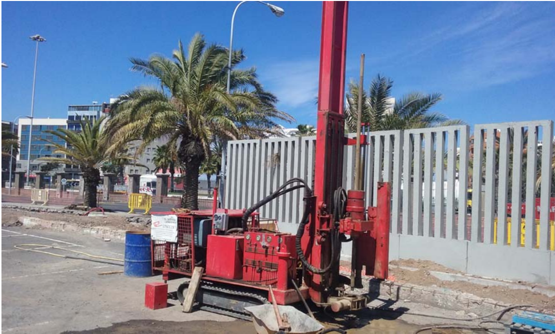
Foto 27: Perforadora instalada en Sondeo 6
