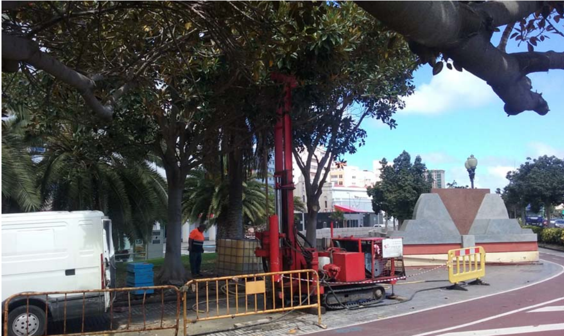
Foto 20: Perforadora instalada en Sondeo 4
