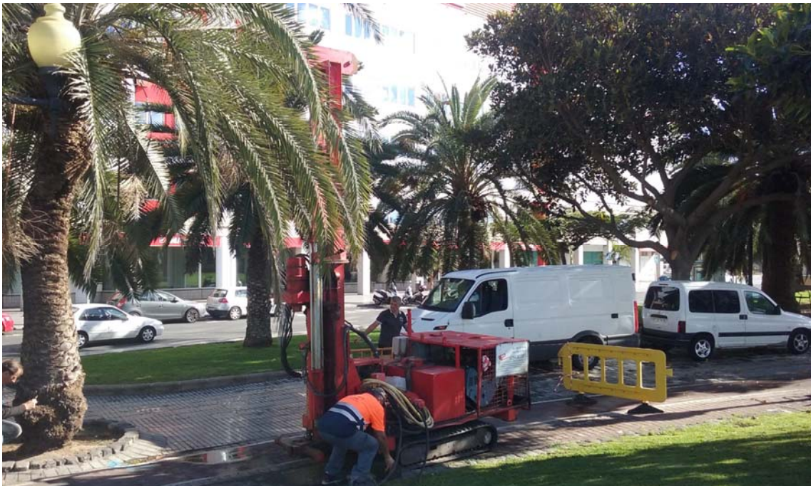
Foto 14: Perforadora instalada en Sondeo 3
