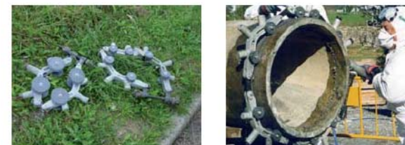
Figura A3.18a Figura A3.18b Herramienta manual de corte para conductos de fibrocemento y detalle de utilización
