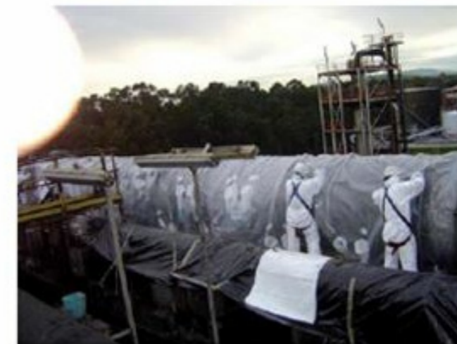
Figura A3.14 Colocación de los sacos de guantes para trabajar en una tubería
