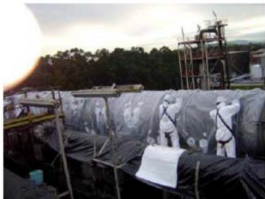
Figura A3.14 Colocación de los sacos de guantes para trabajar en una tubería
