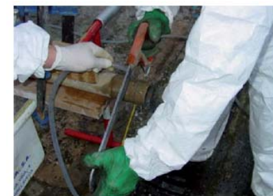
Figura A3.20 Corte de tubería con sierra manual y aporte de agua
