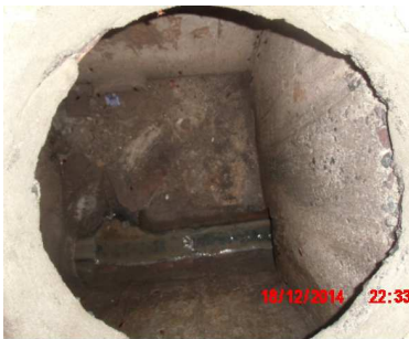
Imagen del interior de un pozo
