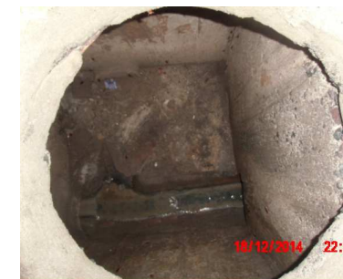
Imagen del interior de un pozo
