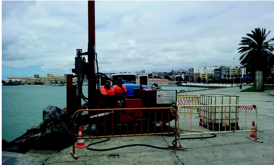
Foto 3: Perforadora instalada en el sondeo 1.1
