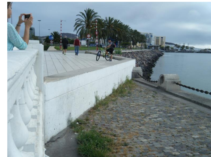
Encuentro entre paseo superior con paseo inferior, este último actualmente inaccesible.
