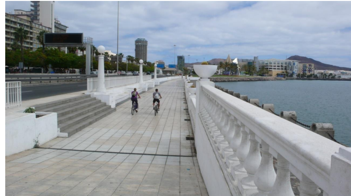
Vista desde la Base Naval hacia el norte. Se aprecia las acometidas para la recogida de pluviales, al final de la rampa y a lo largo de todo el paseo en el lateral derecho de la foto.
