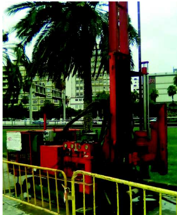
Foto 144: Perforadora instalada en el sondeo 12.2
