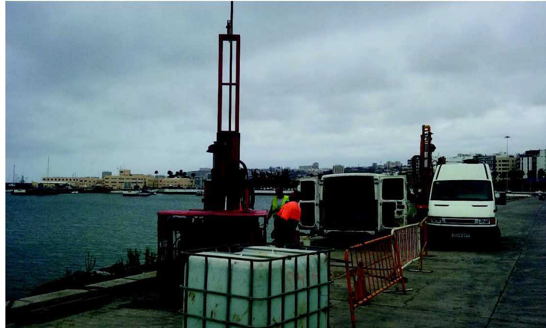
Foto 39: Perforadora instalada en el sondeo 4.1
