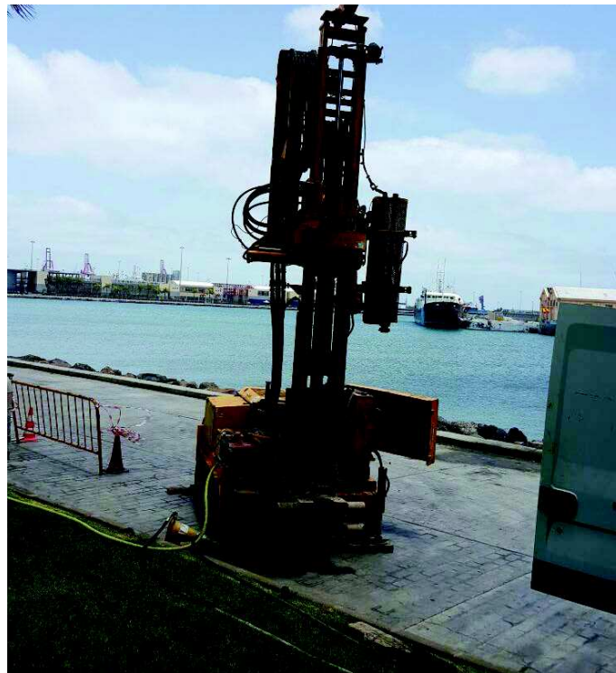
Foto 56: Perforadora instalada en el sondeo 5.2
