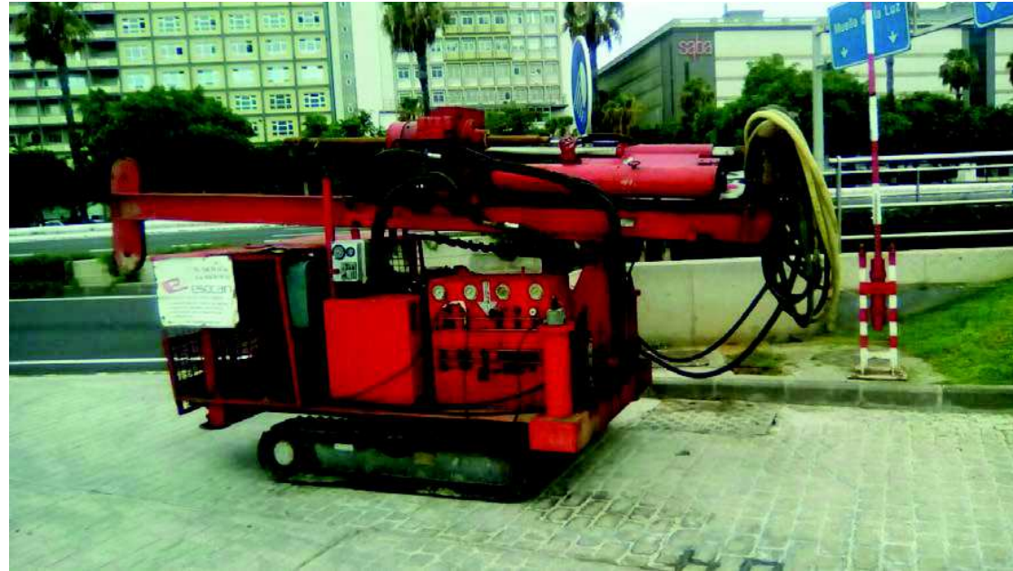
Foto 171: Perforadora instalada en el sondeo 14.2
