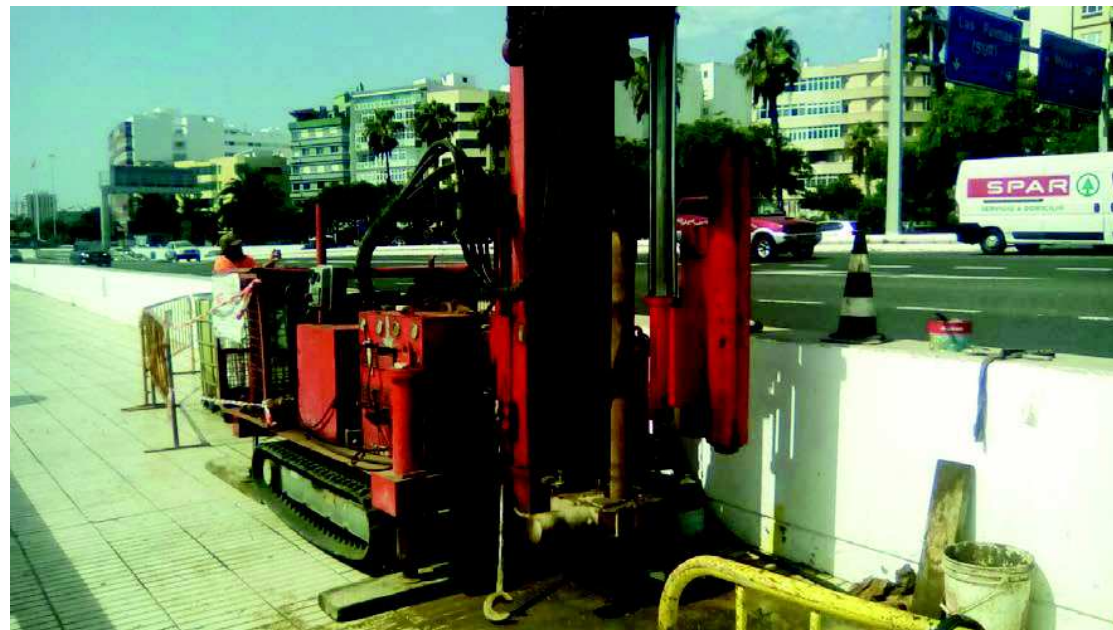
Foto 212: Perforadora instalada en Sondeo 17.2
