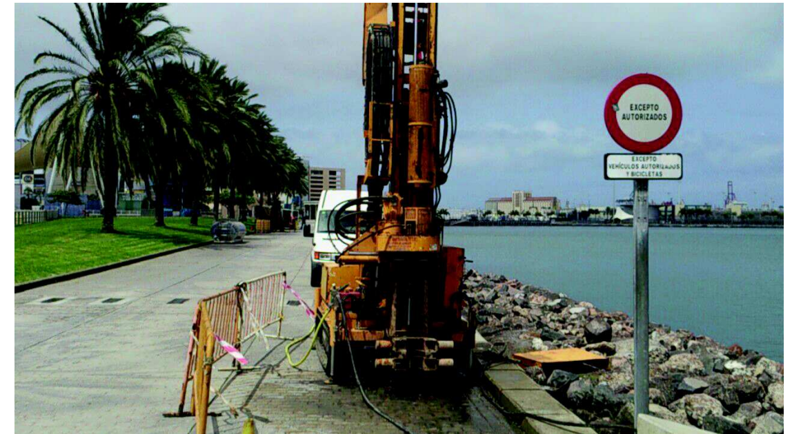
Foto 165: Perforadora instalada en el sondeo 14.1
