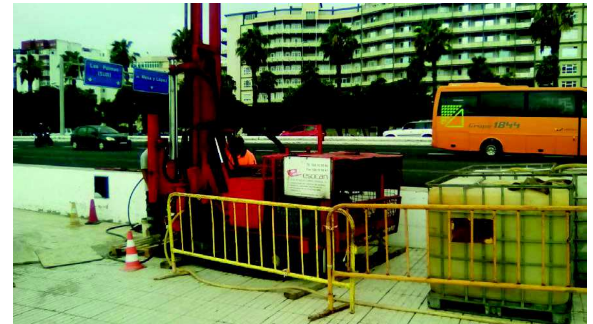
Foto 198: Perforadora instalada en el sondeo 16.1
