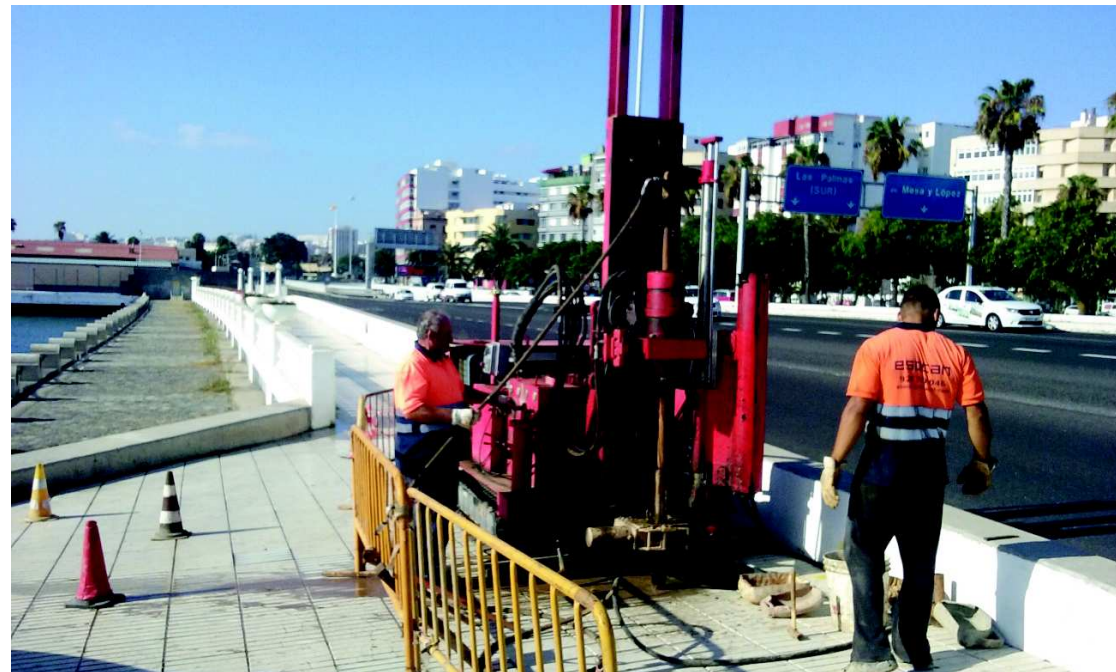
Foto 184: Perforadora instalada en el sondeo 15.2
