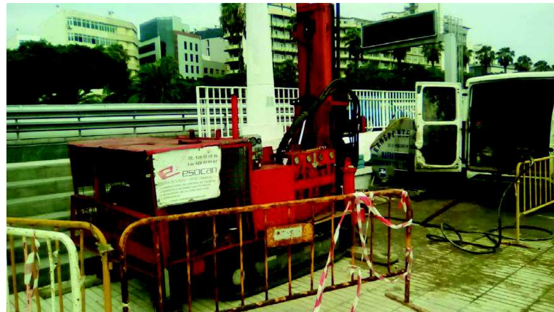
Foto 240: Perforadora instalada en el Sondeo 19.2
