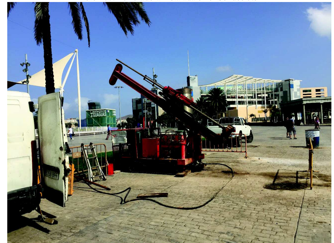
Foto 280: Perforadora instalada en el Sondeo 5.3
