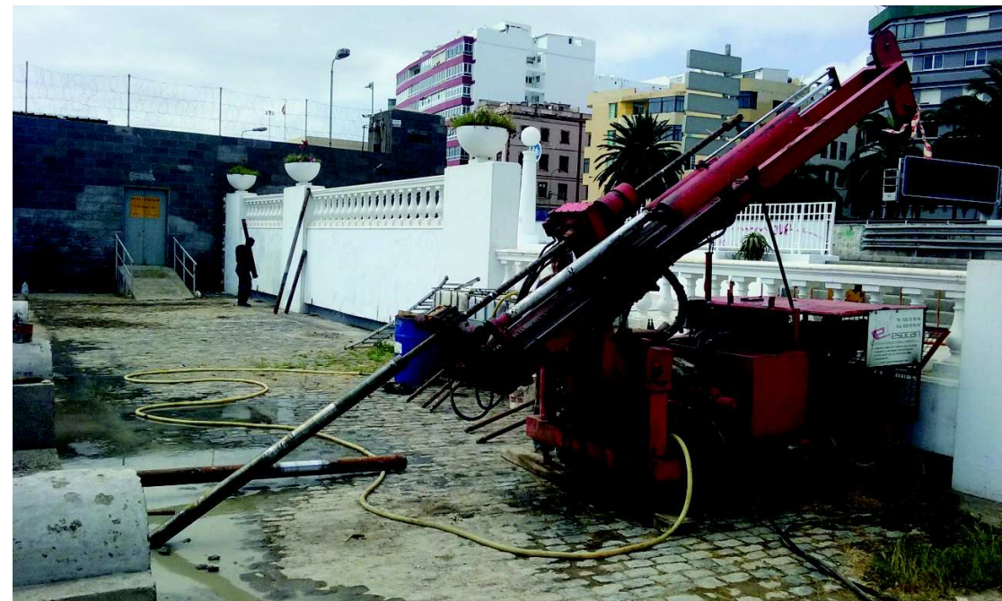
Foto 344: Perforadora instalada en el Sondeo 19.3
