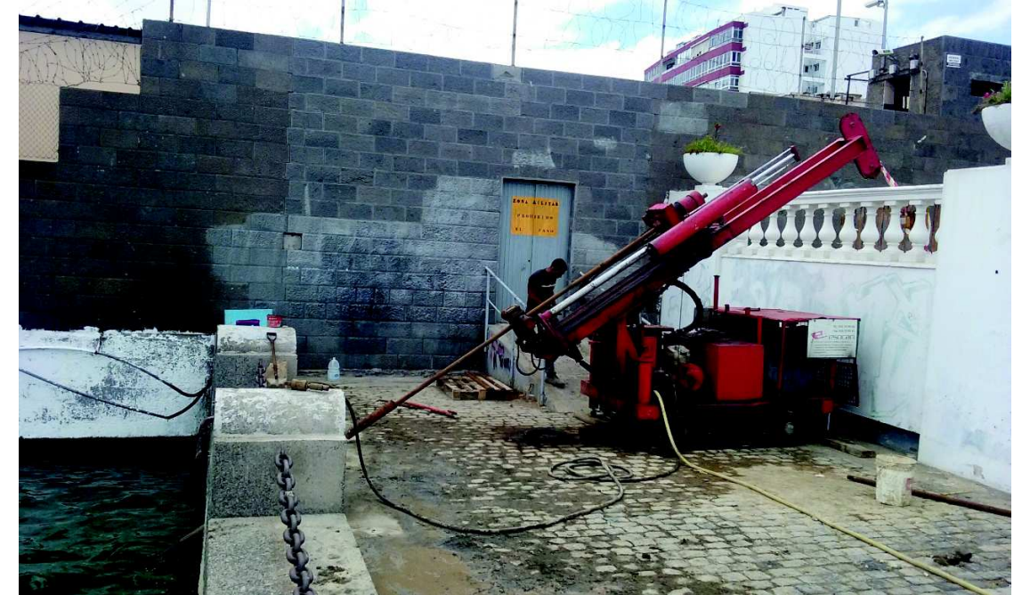
Foto 353: Perforadora instalada en el Sondeo 20.3
