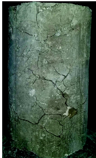
Muestra antes de la rotura
