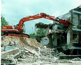
Demolición de muros a máquina ( http://www.cybervillagemall.com )
