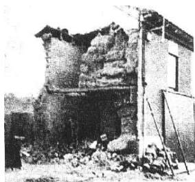
Demolición de edificación
