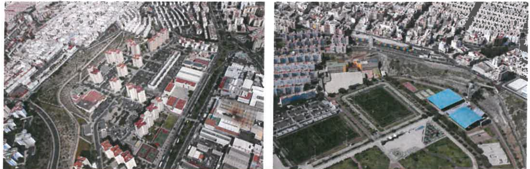
Relación fisiográfica de ruptura con la ladera hacia el Polígono Cruz de Piedra (izquierda) y el Parque de Las Rehoyas (derecha).
