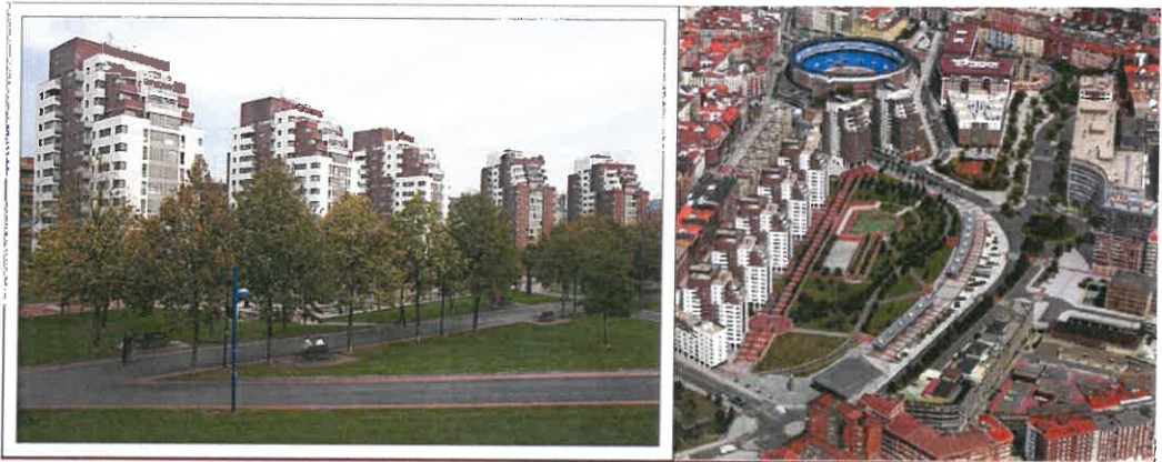
Relación del conjunto edificado de alta volumetría con zonas de espacios libres y dotaciones. Amézola, Bilbao.
